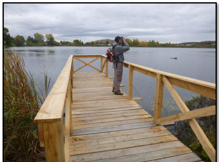
Les petites passerelles sont dorénavant très stables pour les observateurs d'oiseaux. La grande passerelle, quant à elle, a été élargie pour faciliter l'observation.
