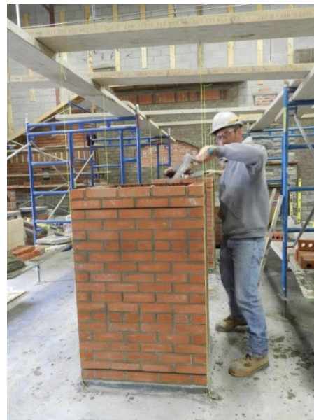
Construction de la 1ère section
